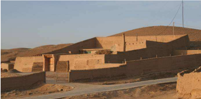
Maison en terre et son enceinte
