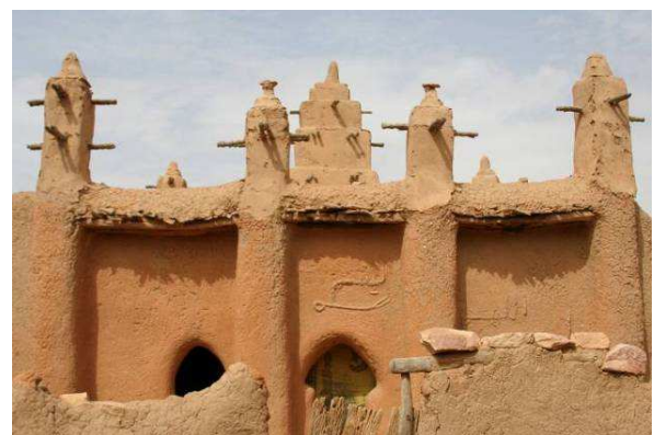
Mosquée en banco
