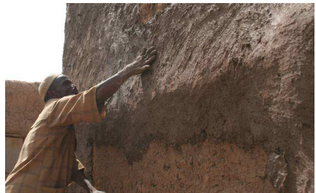
Réalisation d'un enduit en banco avant l'hivernage
